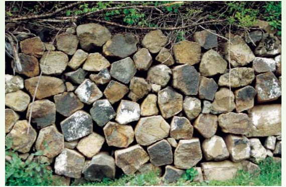
Bahçe duvarlarında bazalt sütunları
