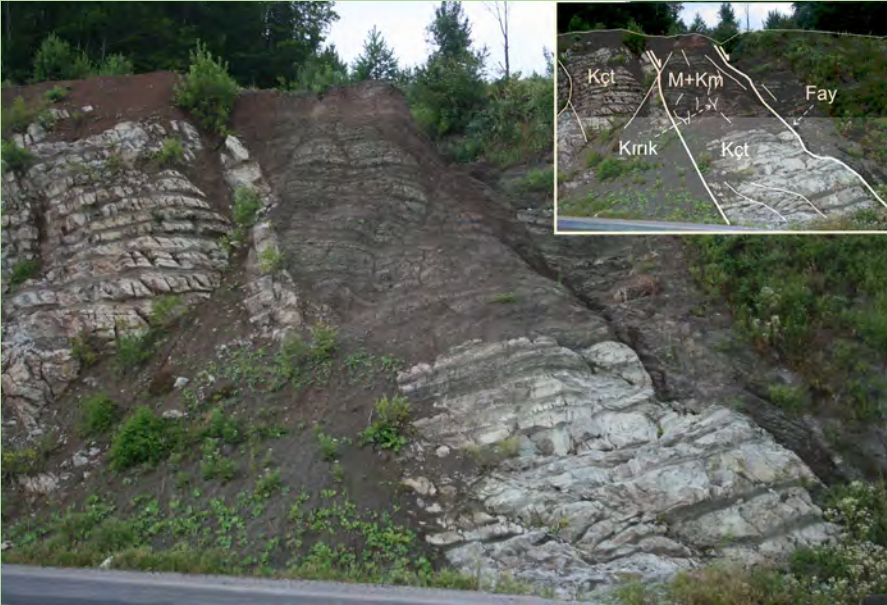
Himmetpaşa Formasyonu'n- daki düşey ve normal atımlı faylar (M:marn, Km:kumtaşı, Kçt:kireçtaşı)
