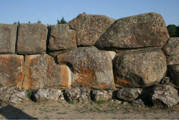
Sur duvarlarında taşların örölme şekli.
