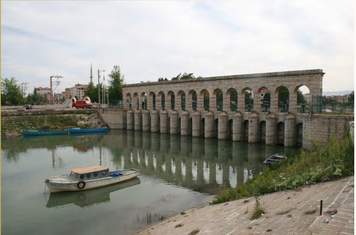
Beyşehir Gölü regülatörü (Yapım tarihi: 1905)
